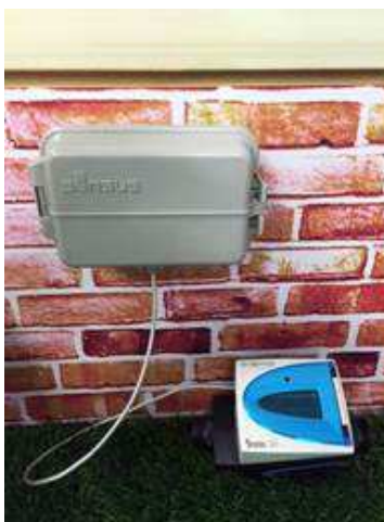
<「FlexNet™」と接続した水道スマートメーター>
